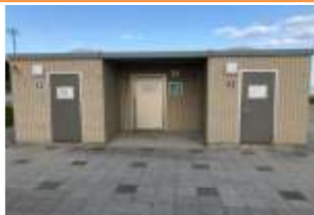
バリアフリー化の対象となる現地のトイレ棟
